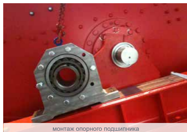
монтаж опорного подшипника
