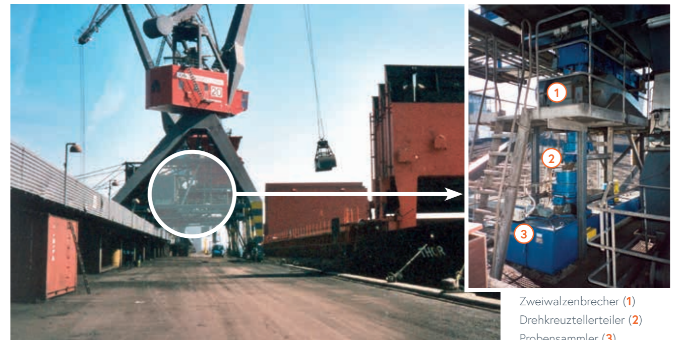
Probenahme im Entladekran für Kohle
